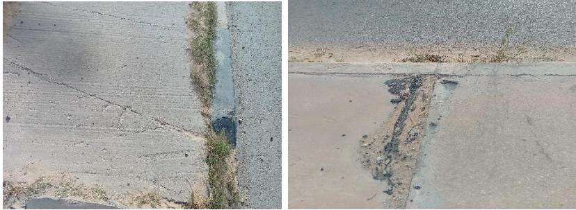
الشكل 4. التشققات وصعود حشوة الفواصل بأرصفة المشاة المنفذة بالخرسانة الاسمنتية العادية
