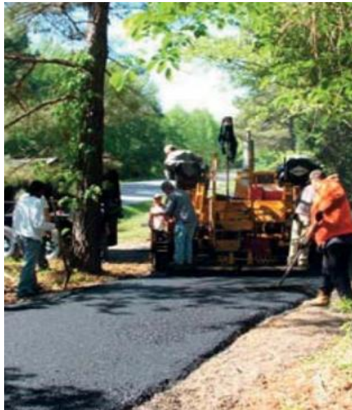
الشكل 1. رصيف مشاة منفذ بخلطة التكرسية السطحية الإسفلتية (Hot Mix Asphalt Pavement Design Guide, 2008)
